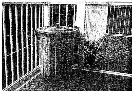
写真Ⅲ-3： 大型ポリバケツ利用の防火用水。この中に小型バケツ2ヶを浮かせてある。バケツに一杯の水で消せたボヤに消火器1本を噴射しても消火できないことが実際に起こった。
