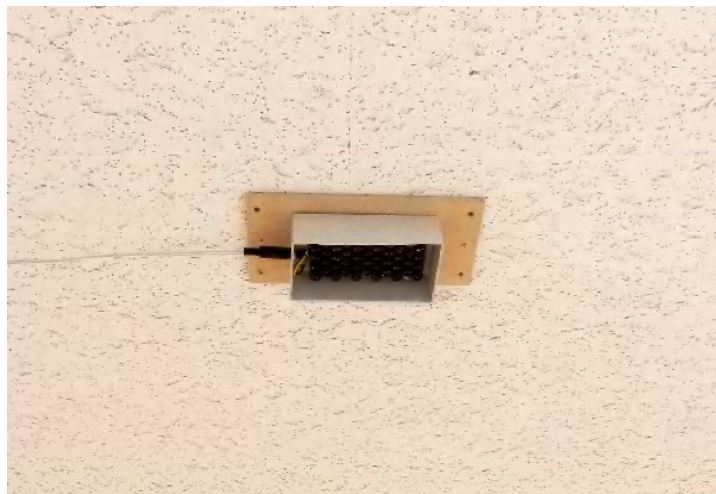
図 3. 天井に設置したパラメトリックスピーカー。本報告書別項（岩元ら）で用いたスピーカーの半数の素子（50 素子）で作成した。
