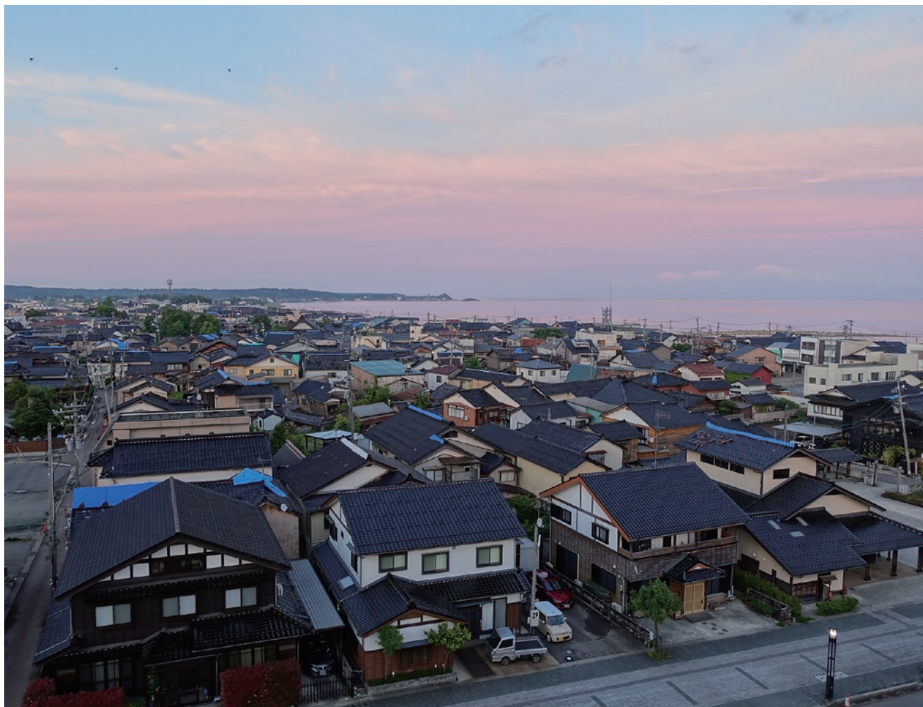
珠洲市空撮・市街地2(撮影日2024/5/13) 出典：令和6年能登半島地震アーカイブ(提供者：石川県)/CC_BY-NC-SA
