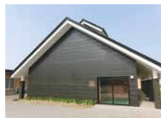
カフェ建物の全景
