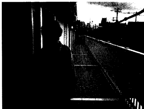
写真IV-8: 避難路兼用のバルコニー。2階の各個室からバルコニーに出られる構造。バルコニーは階下への非常階段につながっている。
